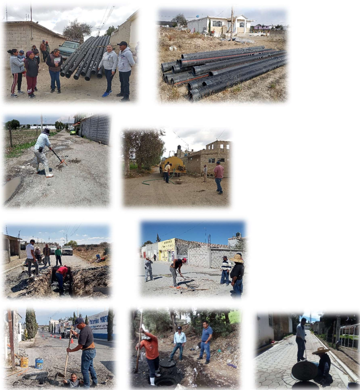
Figura 3.1. Apoyo de Servicios Municipales a la regiduría y departamento de Obras públicas, al mantenimiento de la red de drenaje en el municipio de Cañada Morelos.
